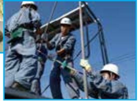
建設技術を駆使した 文化祭アーチの製作
